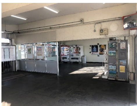
← 現状の飯塚駅 旧駅構内店舗跡 スペース
